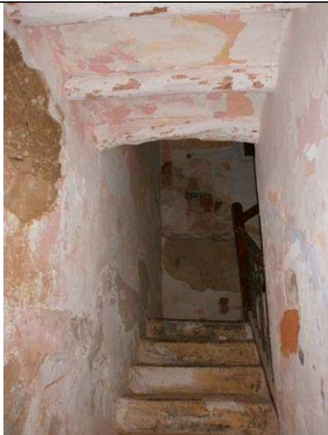
le début de l'escalier
